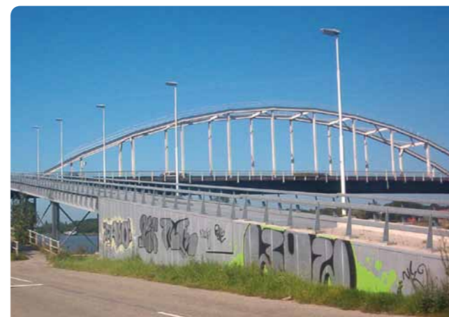
EMERGENCY EXIT Location: Maarssen (NL) Tonnage: 110 Client: Heijmans Staalbouw
