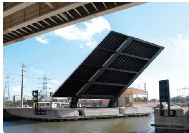
DRAWBRIDGE CANAL LEUVEN-DIJLE Location: Wilsele (BE) Tonnage: 70 Client: Roegiers
